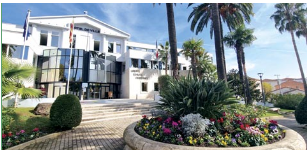
Ravalement de la façade et remplacement des portes d'entrée de l'Hôtel de Ville.
