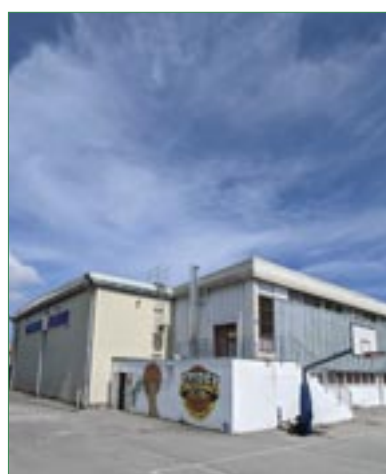
Réfection de l'éclairage et rénovation du gymnase Allinéi.
